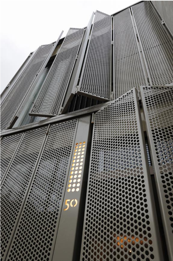
Wenslauerstraat 50. De voorgevel met stalen luiken, huisnummer en verlichting, doorsnedes nr 48 renovatie (boven) en nr 50 nieuwbouw (onder)
