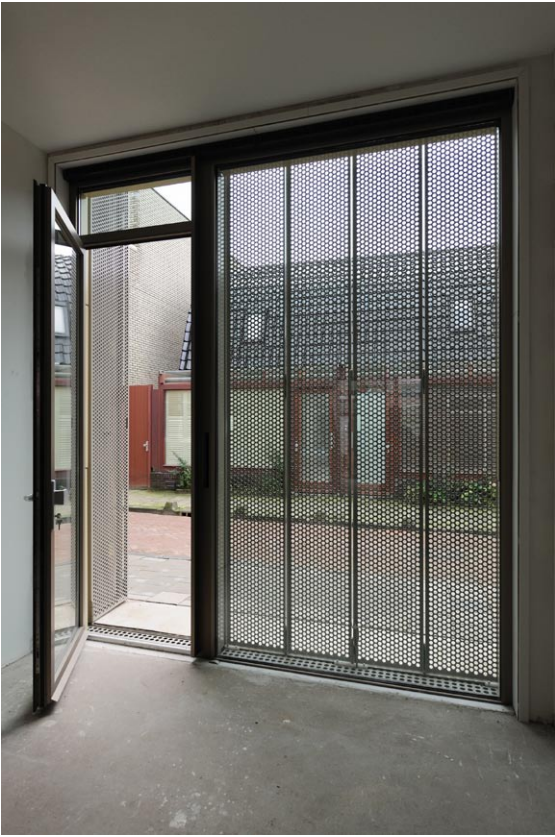
Wenslauerstraat 50. De stalen luiken dienen als zonwering en als 'vitrage' voor de privacy naar de straat
