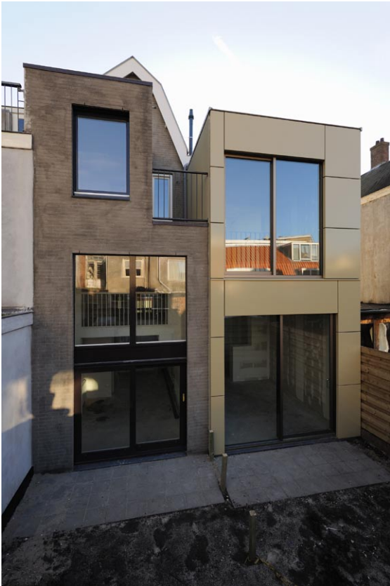
Wenslauerstraat 48 en 50 Achtergevels renovatie (links) en nieuwbouw (rechts)
