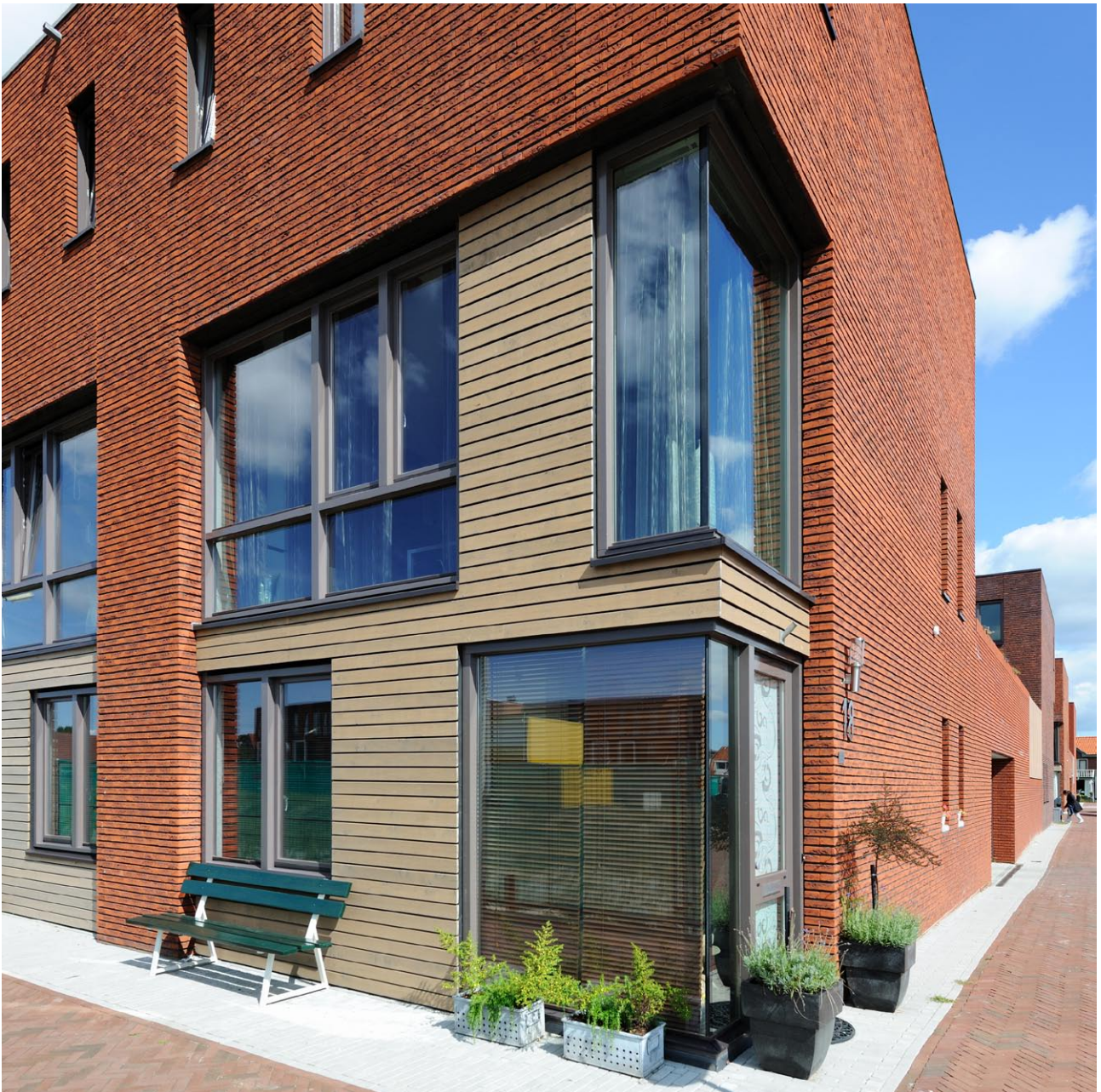
De open glazen hoeken van de blokken verlenen de gebouwen een sculpturale uitstraling. De margestrook nodigt bewoners uit om bezit te nemen van de stoep.
