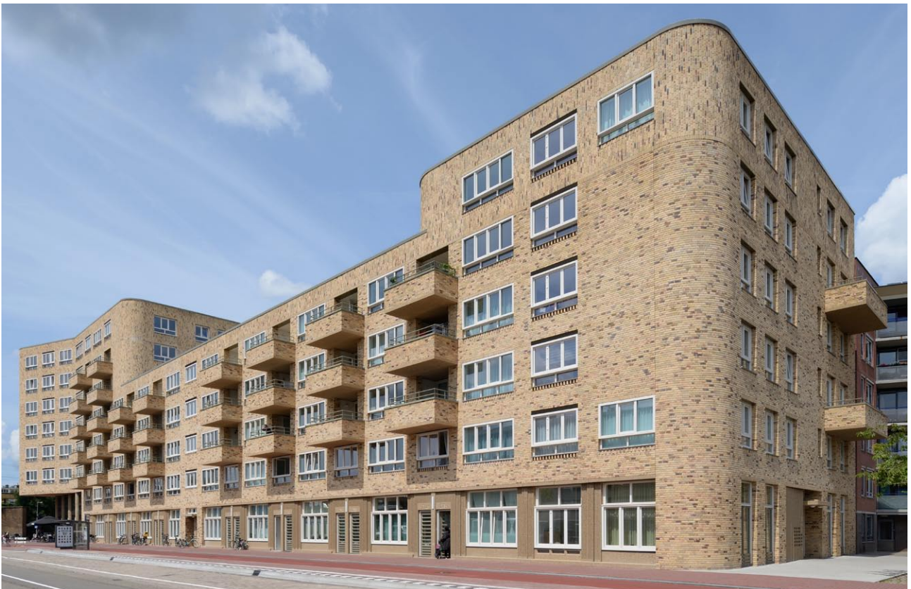
Gevel aan de Insulindeweg. De gebouwhoogte verspringt van 8 lagen op de kop met de Celebesstraat naar 5 lagen in het middenstuk naar 6 lagen op de hoek met de Riouwstraat.
