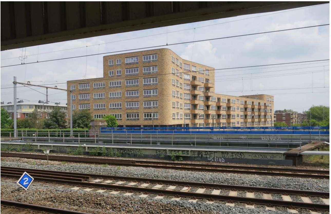
De kop van het gebouw aan de Celebresstraat gezien vanaf het Muiderpoortstation. Het sculpturale volume levert een interessante en herkenbare contour op.
