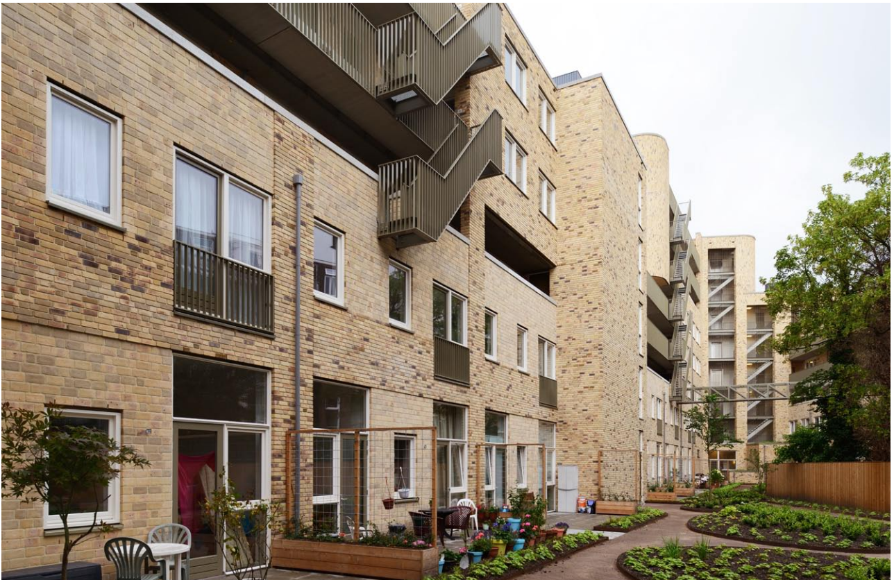
Binnenhof, de gevels aan het binnenhof zijn informeler dan de straatgevels, de galerijontsluiting is kleinschalig, de verspringende bouwmassa en de stalen trappen en balustrades verlevigen de gevels.
