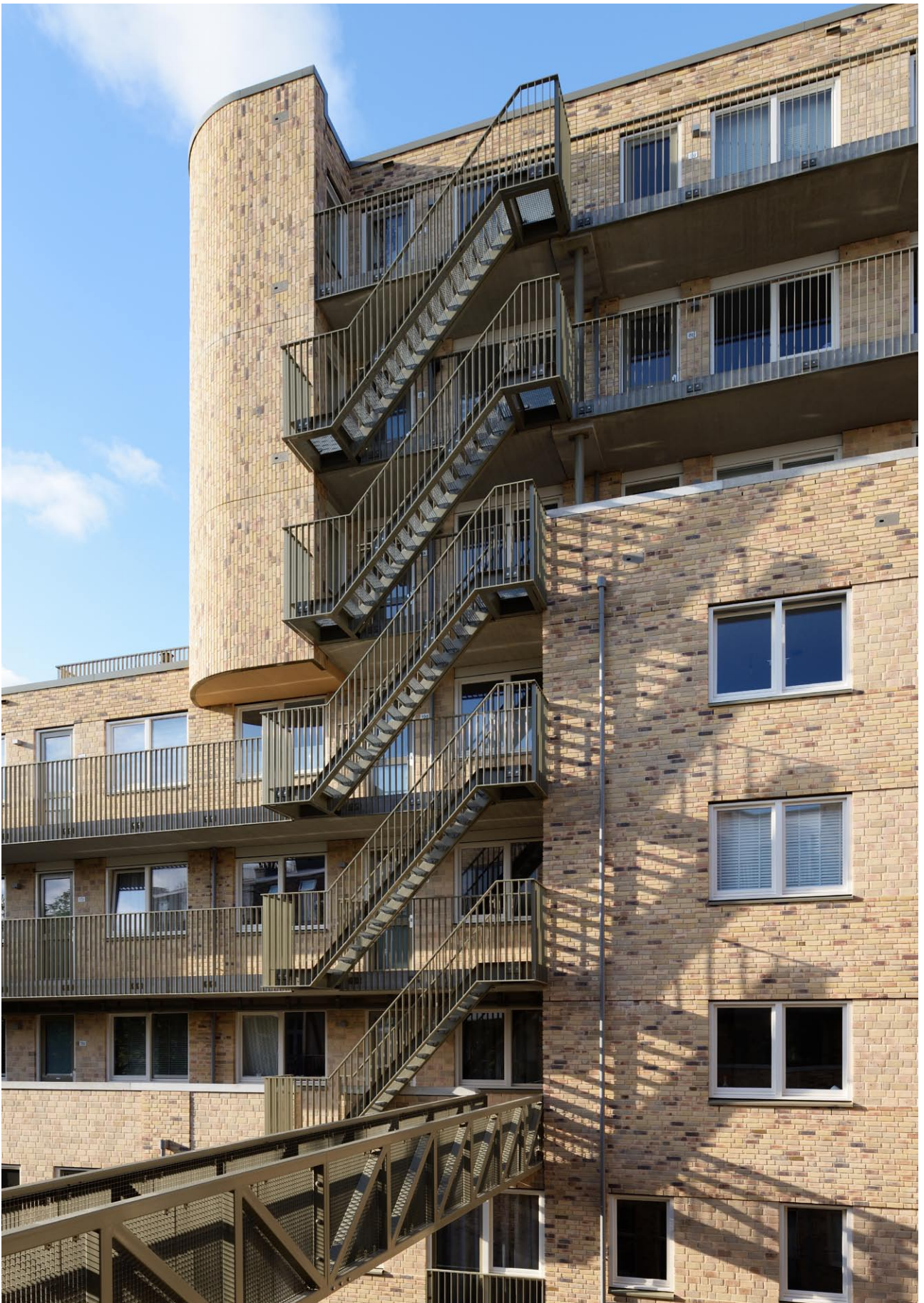
Achtergevel van de Insulindeweg met loopbrug en vluchttrappen die de galerijen met elkaar verbinden.
