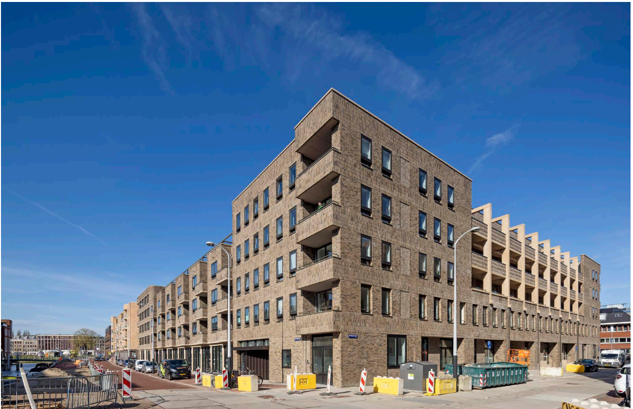
Hoek oost met op de noordoost-gevel galerijen aan de straat die worden geaccentueerd met een betonnen frame.
