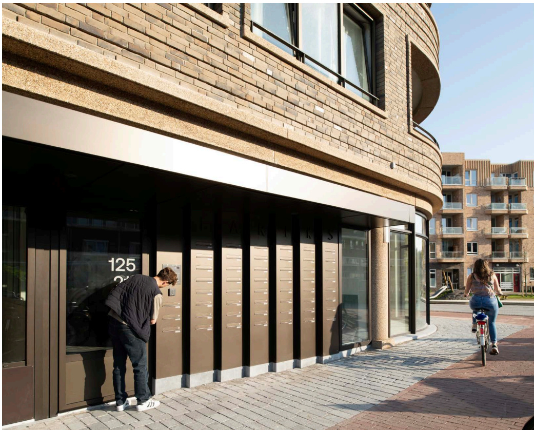
Detail gevel; brievenbussen en entree
