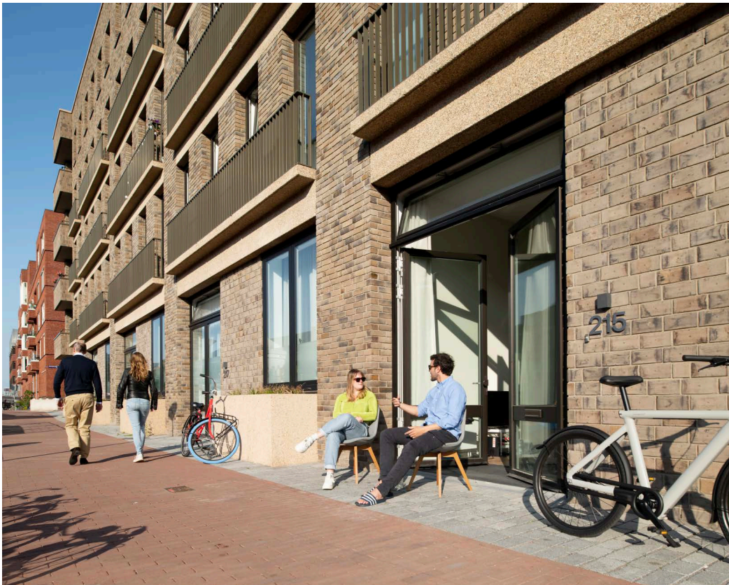
Detail gevel; ruimte voor ontmoeting
